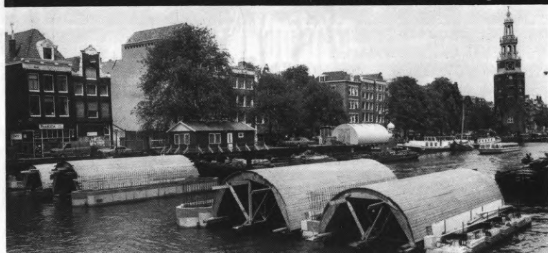
Wie früher: Brückenbau mit Leegerüsten
