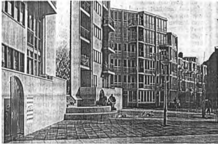
Der Halbkreis ist mehrschalig: vor den Häusern Mauern mit Durchgängen, darüber Logen.
