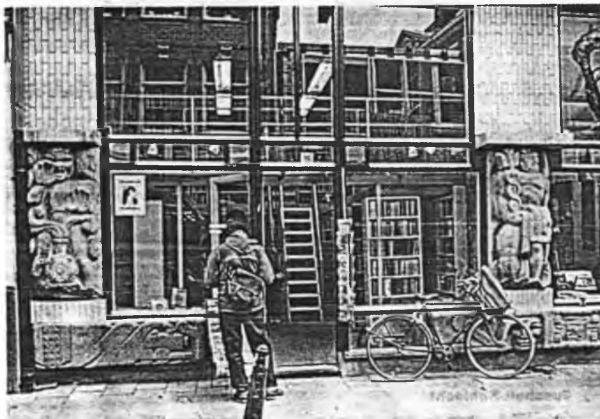
In der metallischen Fassade Skulpturen vom abgerissenen Ringbahnviadukt.
